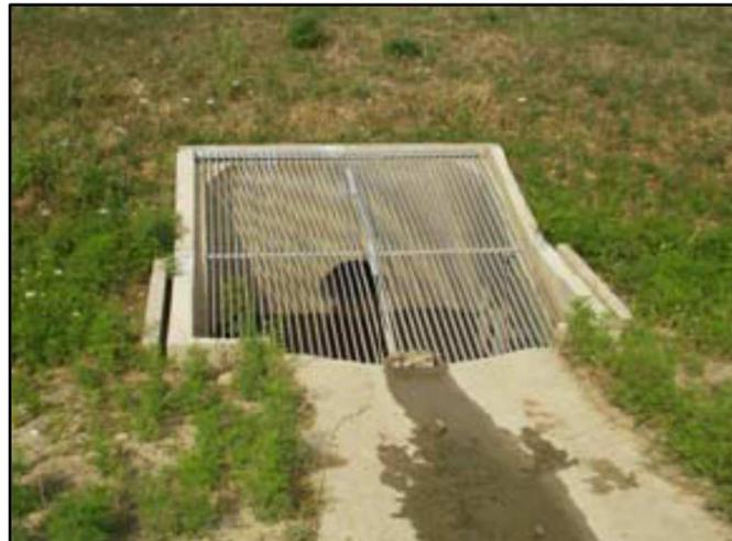
**Figure 7 : Grille de protection sur ouvrage de sortie**
