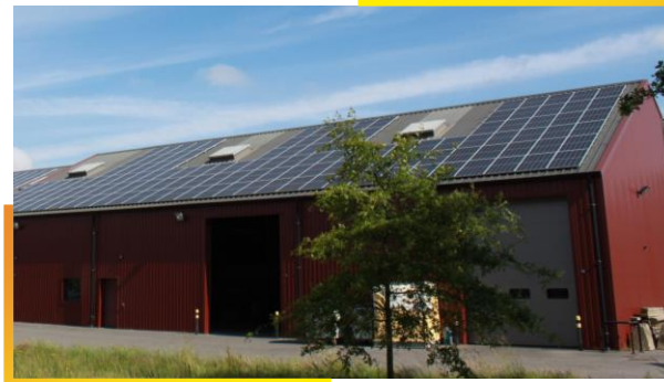
Installation sur toiture
